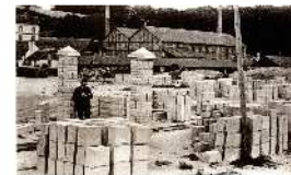
briquerie de St - Ilan: voie ferrée avec un stock de pierres artificielles prêts pour le départ (1904)
