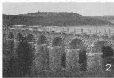
Viaduc du Vau Hervé en Cesson
