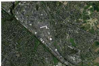
Photo aérienne de la zone commerciale (2017)
